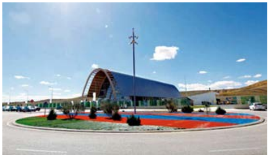
Centro de Tratamiento de Resinas de Almazán.
