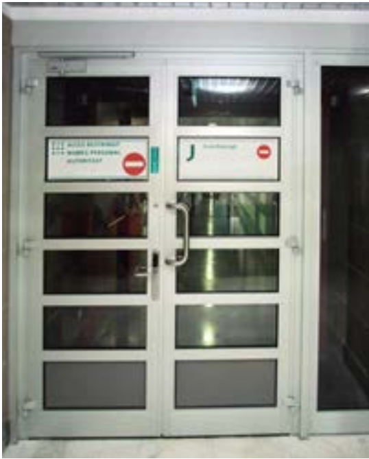
Acceso a área restringida.
